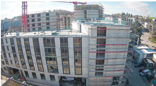
Blick auf die Baustelle «Am Stadtplatz» Kloten
