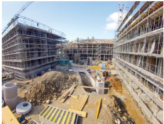
Blick auf die Baustelle Tannenrauchstrasse in Zürich-Wollishofen.
